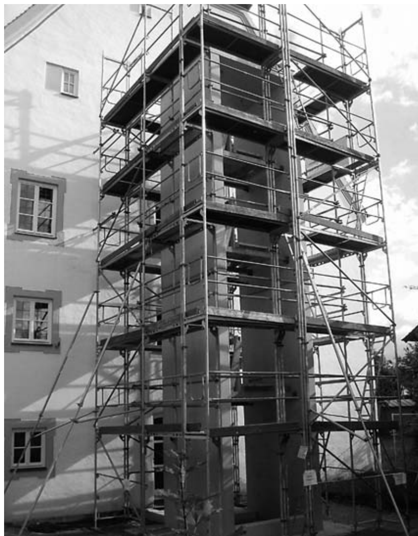
In die bereits fertig gestellte Betonhülle wird momentan der Aufzug eingebaut
